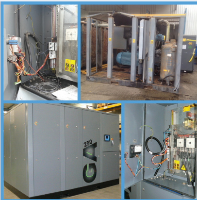
Réusinage de compresseur
